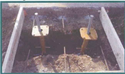
Prep for Concrete Pour
